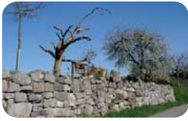
Mur de pierres sèches
